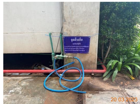
ภาพที่ 2-11 จุดล้างทำความสะอาดล้อรถบรรทุก
