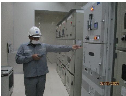
อาคารหม้อแปลงไฟฟ้า : 2nd Floor : ห้อง Switchgear 6.9 Kv : ตู้ควบคุม J04
