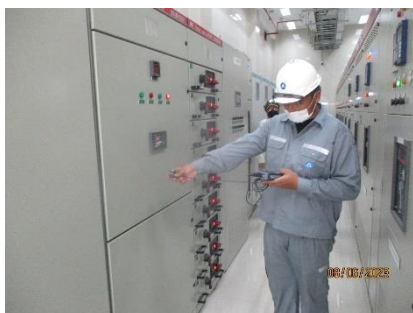
อาคารหม้อแปลงไฟฟ้า : 2nd Floor : ห้อง Switchgear 400 v : ตู้ควบคุม MNS Feeder
