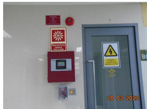
ภาพที่ 2-35 ระบบตรวจสอบ ตรวจจับ และสัญญาณเตือนภัยแบบอัตโนมัติ
